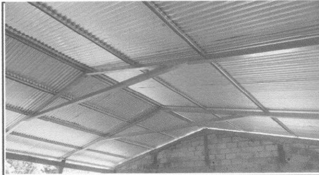
Foto 2: Se observa terminado la instalacion de estructura de techo de metal en el modulo 2
