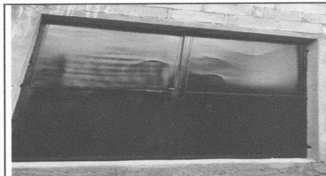
Foto 3: Se observa terminado la instalacion de puertas de metal en el modulo 2
