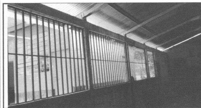
Foto 5: Se observa terminado la instalacion de balcones en el modulo 2
